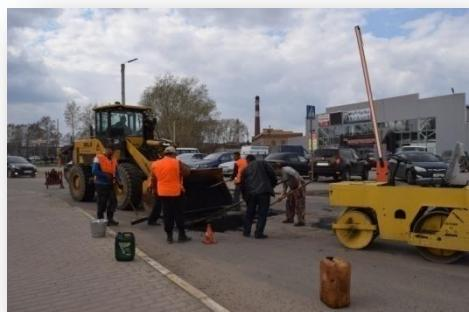
Силами МКУ «Благоустройство и Озеленение» в течение всего года регулярно проводился ямочный ремонт дорог струйно-инъекционным методом с использованием специальной установки. Общий объем работ по ямочному ремонту автодорог в 2016 году составил 8,5 тысяч м<sup>2</sup>, что на 30% больше, чем в 2015 году (6,5 тысяч м<sup>2</sup>).
