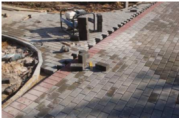
Мощение на жестком основании
