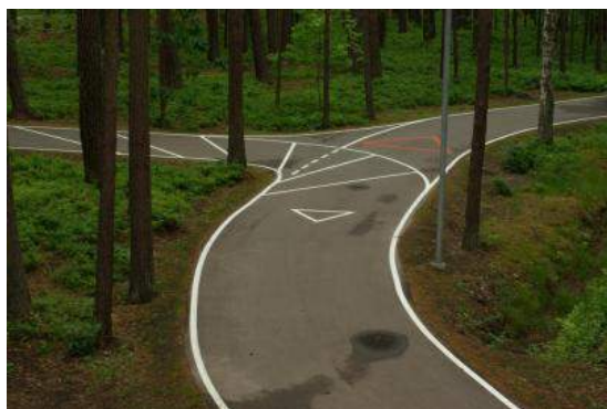
Асфальтирование дорожек и площадок роллердрома
